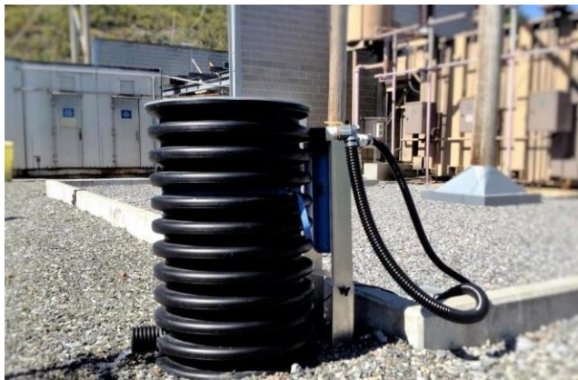
Petro Barrier Pompé PTB 24 en dehors de la rétention, connecté à une pompe pour filtrer le trop-plein de la fosse déportée - NATIONAL GRID
