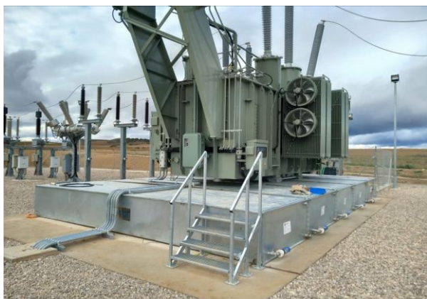
Bac de rétention modulaire anti feu ERT-MODULO 5 avec escalier d'accès et cartouches de filtration PETRO PIT - REPSOL
