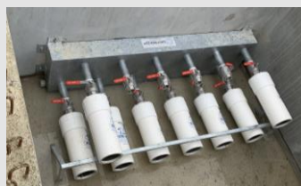
SKID PIPE pour drainage gravitaire de fosse déportée, approx. 200 L/min
