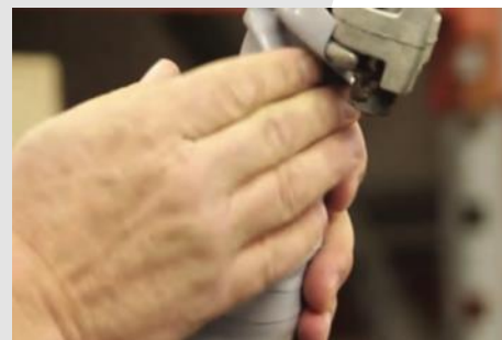
3 Evacuez l'air en appuyant fermement sur le ruban
