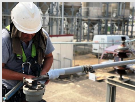
2 Effectuez un second tour pour une isolation de 35 kV
