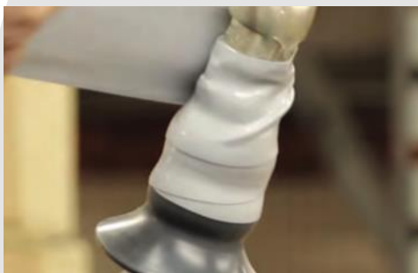
2 Effectuez un second tour pour une isolation de 35 kV
